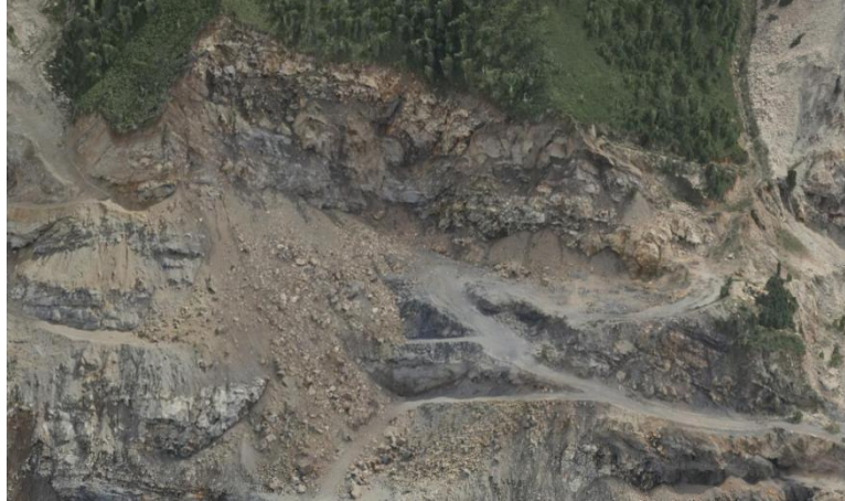
照片 2-6 3 号露天采坑南侧边坡崩塌地质灾害点
