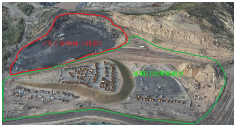
照片 2-15 1号工业场地（西部）
