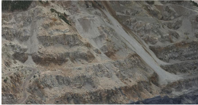
照片 2-5 2 号露天采坑南侧边坡崩塌地质灾害点
