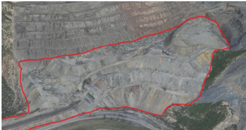
照片 2-7 1 号外排土场（西部）
